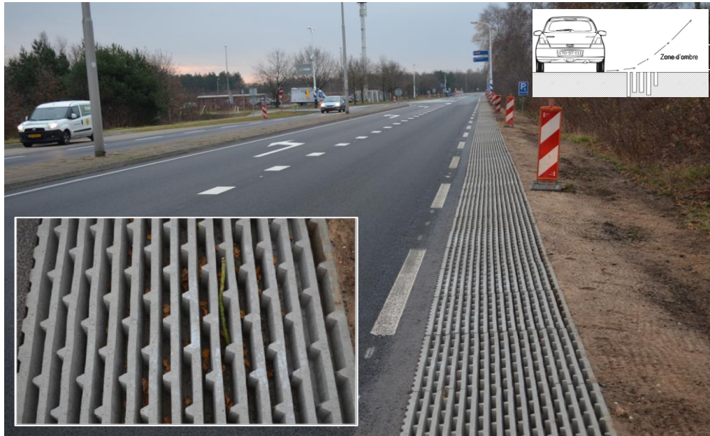
Figure 74 – Whisstone: bord de chaussée diffractant, site expérimental de Soesterberg (Pays-Bas) (source: www.mplusp.eu )
