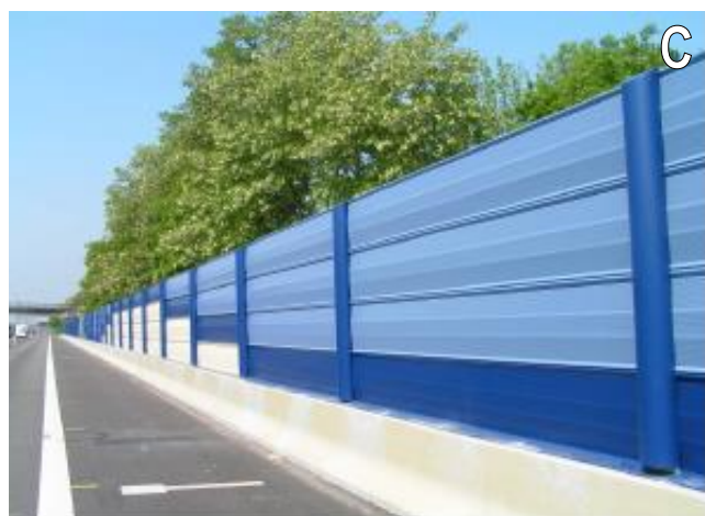
Figure 62 – Dispositifs métalliques: A = verticaux, B = inclinés, C = horizontaux, D = revêtements de parois
