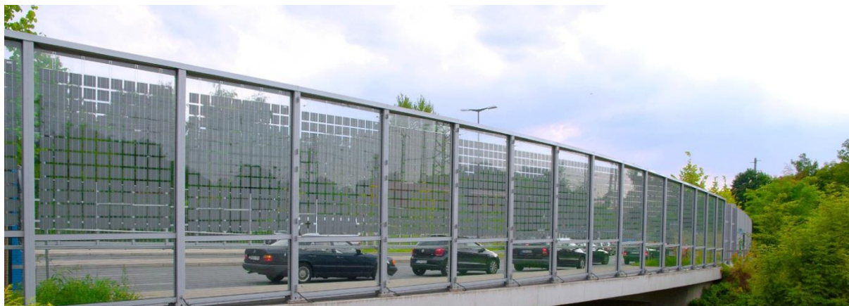
Figure 72 – Exemple d'écran avec éléments photovoltaïques
