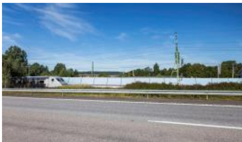
Figure 73 – Projet NOISUN: écrans antibruit à panneaux solaires
