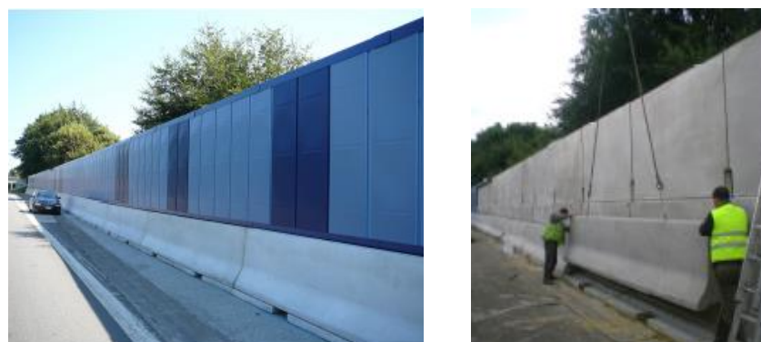
Figure 63 – Exemple d'écran antibruit autoportant en béton et de sa mise en œuvre (revêtement acoustiquement absorbant métallique)
