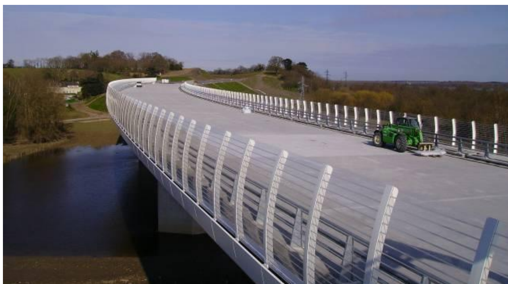
Figure 47 – Ecrans de forme courbe afin de réduire les réflexions multiples
