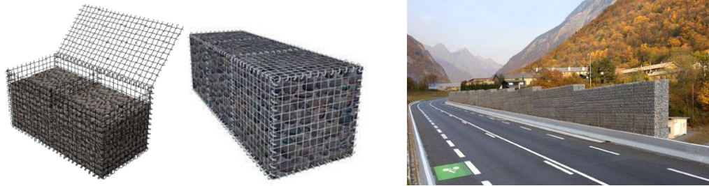
Figure 67 – Gabions: casiers en treillis métallique remplis de pierres (gauche) et écran antibruit en gabions (droite)
