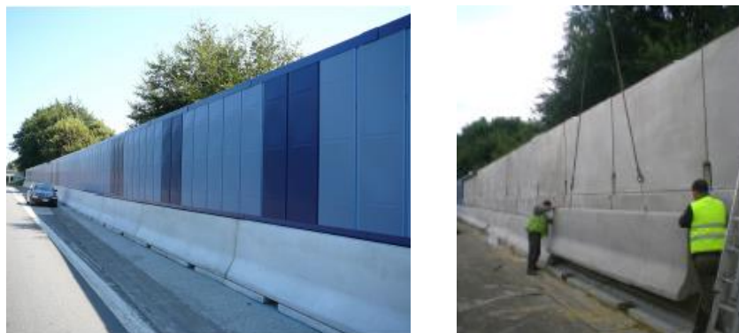
Figuur 68 – Voorbeeld van (aanbrenging van) zelfdragend betonnen geluidsscherm met geluidsabsorberende bekleding van metaal
