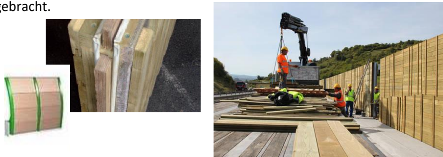
Figuur 65 – Voorbeelden van geluidsschermen van hout en van de aanbrengingswijze
