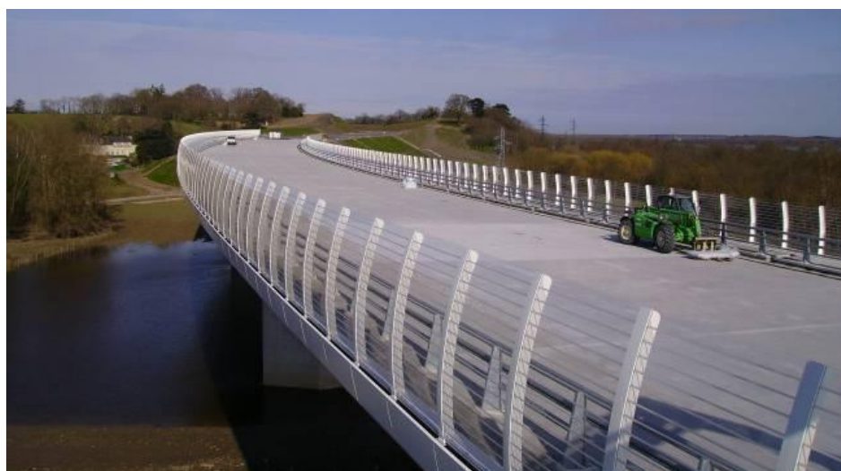
Figuur 47 – Gebogen scherm voor beheersing van meervoudige reflectie
