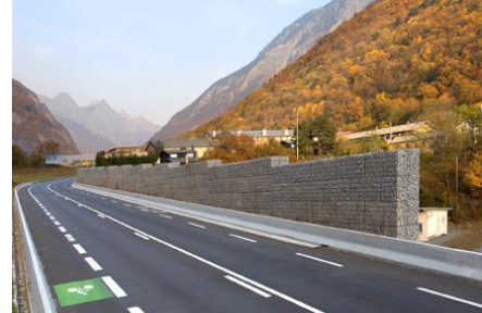
Figuur 72 – Schanskorven: met stenen gevulde metalen kooien (links) en als elementen van een geluidsscherm (rechts)
