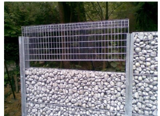
Figuur 73 – Voorbeelden van kleur- en textuurmogelijkheden (links) en van dunne schanskorven als bouwelementen voor een muur (rechts)
