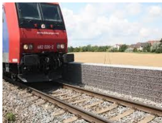
Figuur 42 – Voorbeeld van laag geluidsscherm naast een spoorbaan
