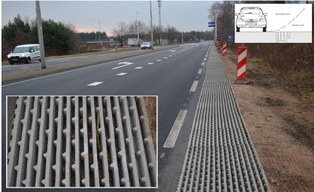
Figuur 79 – Whisstone: proefstrook met diffracterende kant van de rijbaan (Soesterberg, Nederland) (bron: www.mplusp.eu )
