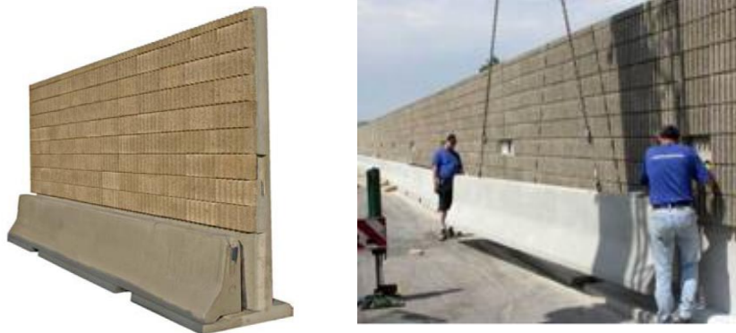
Figuur 67 – Voorbeeld van (aanbrenging van) zelfdragend betonnen geluidsscherm met geluidsabsorberende bekleding van houtbeton
