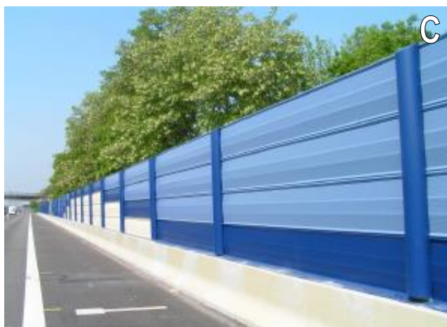
Figuur 62 – Constructies van metaal: A = verticale elementen; B = schuine elementen; C = horizontale elementen; D = wandbekledingen
