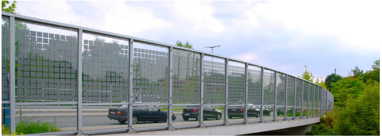
Figuur 77 – Voorbeeld van geluidsscherm met fotovoltaïsche cellen
