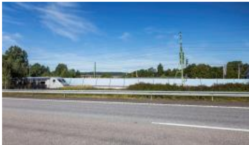
Figuur 78 – NOISUN-project: geluidsschermen met zonnepanelen
