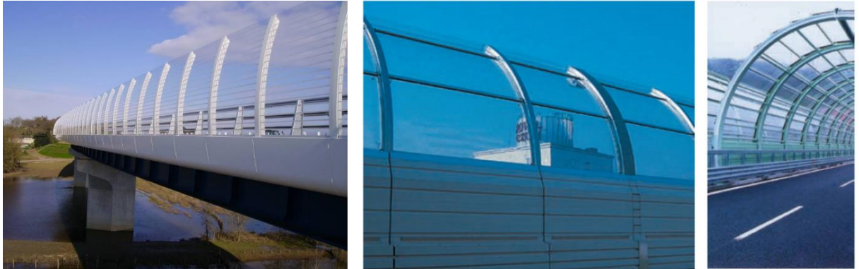
Figuur 59 – Voorbeelden van (visueel) transparante geluidsschermen
