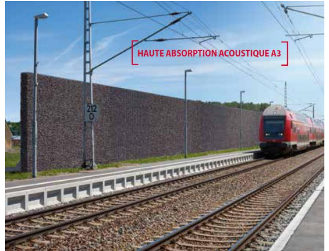
Figuur 74 – Voorbeeld van geluidsscherm met schanskorven met uitstekende geluidsabsorberende en -isolerende prestaties (bron: vbion.com )
