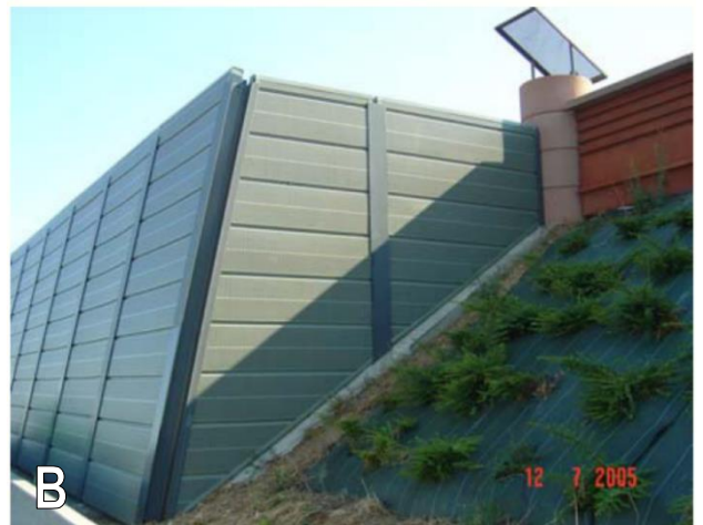
Figuur 63 – Voorbeeld van geluidsscherm van plastic en van de aanbrengingswijze
