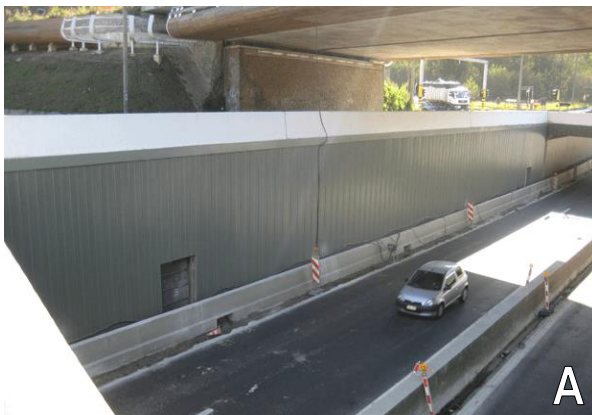
Figuur 63 – Voorbeeld van geluidsscherm van plastic en van de aanbrengingswijze
