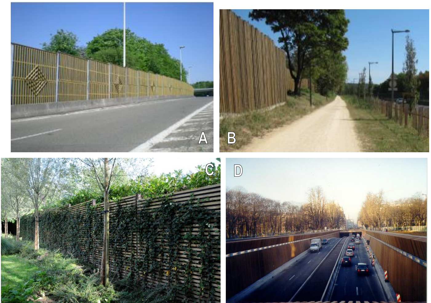
Figuur 66 – Constructies van hout: A, B, C = schermen; C = met begroeiing; D = wandbekleding
