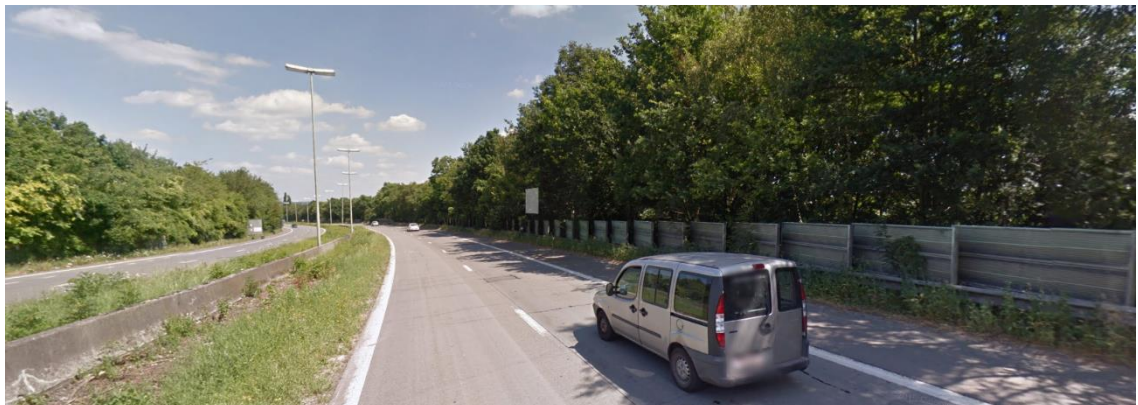
Figuur 60 – Voorbeeld van dynamisch transparant geluidsscherm
