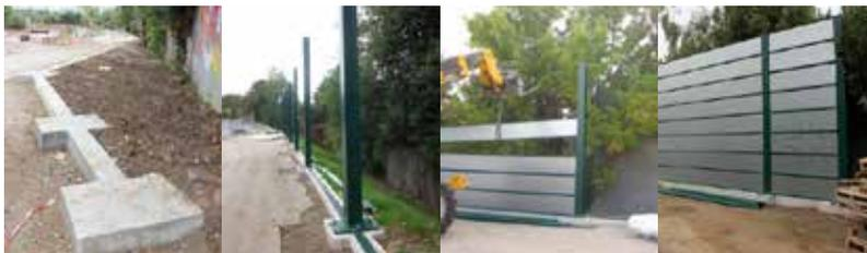
*Montage d'éléments d'écrans préfabriqués, entre deux profilés en H verticaux*
