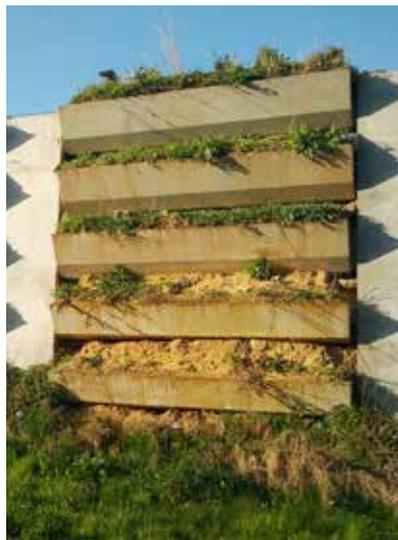
Écran antibruit composé de bacs en béton superposés
