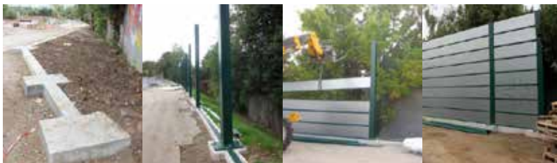
Montage van geprefabriceerde schermelementen tussen twee verticale H-profielen
