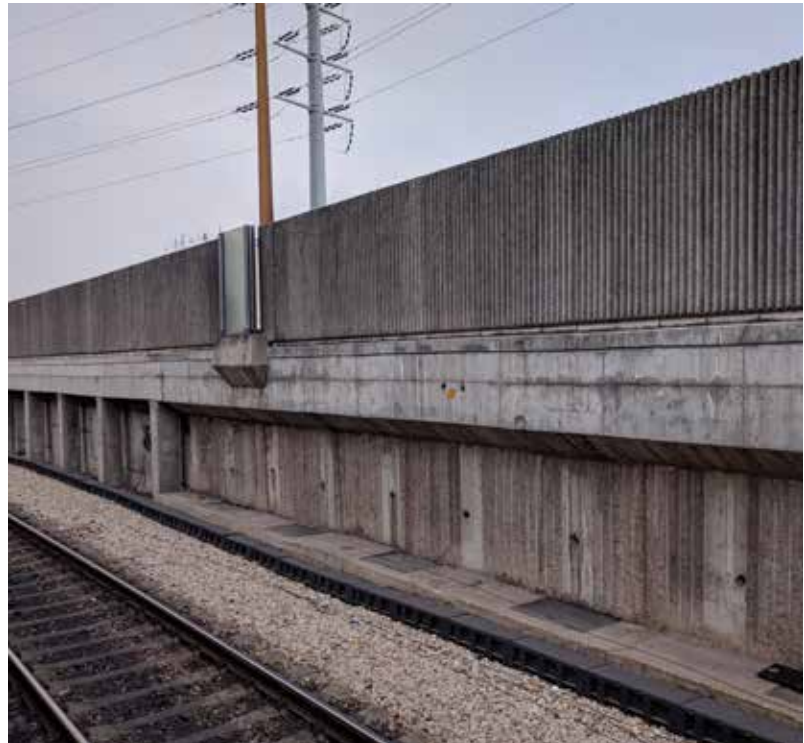
Betonnen scherm met gegroefd motief voor betere geluidsabsorptie
