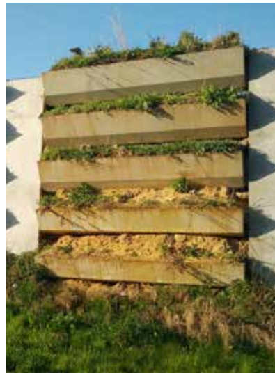
Geluidsscherm bestaande uit op elkaar gestapelde betonnen bakken
