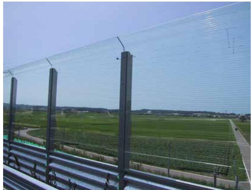
Geluidsscherm in gewapend kunststof (PMMA)
