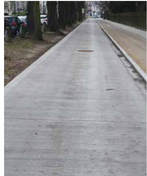
Site propre bus en béton le long du parc du Cinquantenaire
