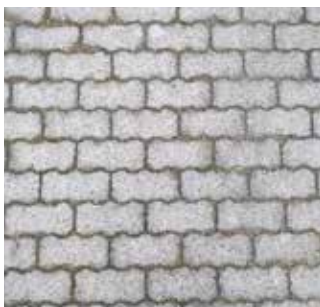
Pavés rectangulaires à bords cannelés pour une meilleure stabilité
