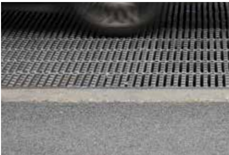
Ventilatioerooster van een tunnel
