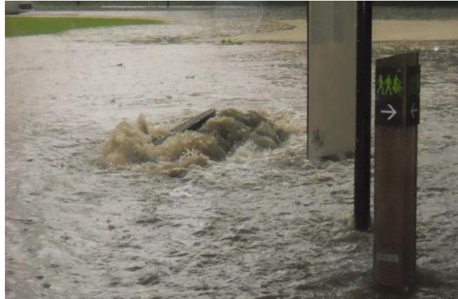
Figuur 3: voorbeeld overstroming afkomstig van een riolering (Bron: Leefmilieu Brussel)
