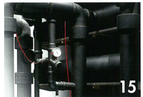
Koudeleidingen correct isoleren
