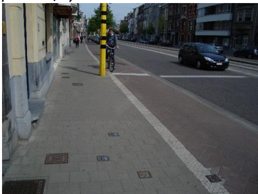
Bande podotactile de séparation entre piétons/cyclistes
