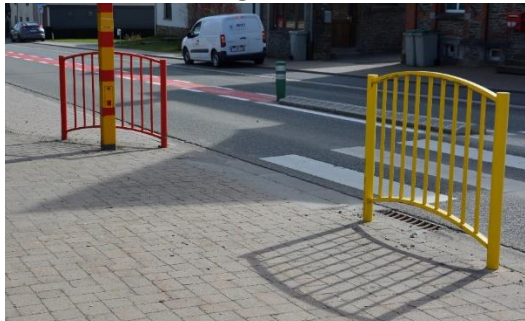
✓ Barrière fixe détectable à la canne
