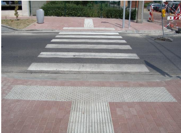
Traversée piétonne accessible : plain-pied et dispositif podotactile
