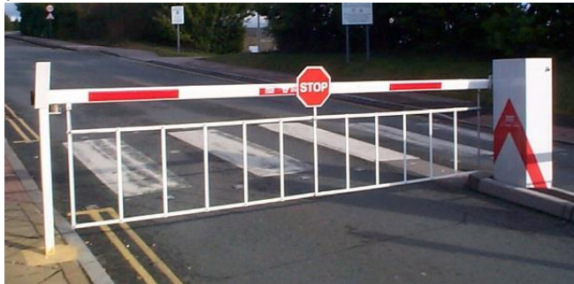
✓ Barrière mobile détectable à la canne
