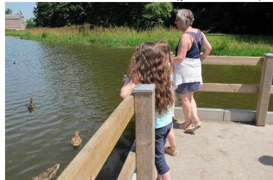
✓ Garde-corps sécurisant, présence de bordure chasse-roue
