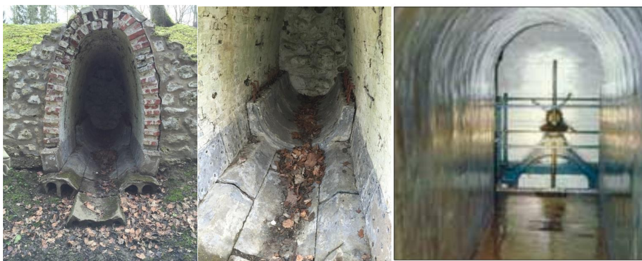
Figure 33 : Reproduction d'une section de la galerie Vivaqua (photo de gauche et milieu) - Serrement de la galerie (photo de droite) - source : VIVAQUA)
