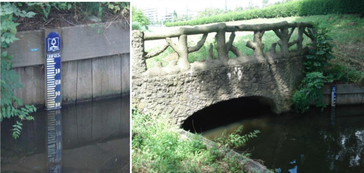
Figure 10 : Localisation des limnimètres de Bruxelles Environnement (ciel ouvert) et Flowbru (pertuis) – exemple en photo : limnimètre Woluwe Out
