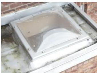
Figure 25 – Coupole à simple paroi- vitrage de type 1
