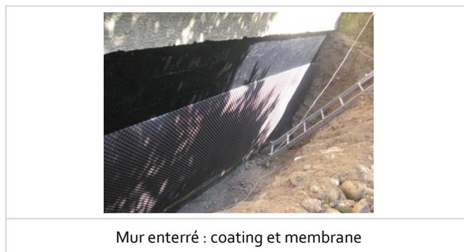
Figure 5 – Protection contre l'humidité du sol (mur de type 2)
