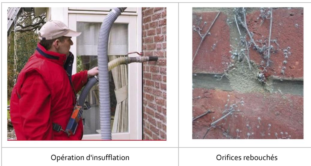
Figure 18 – Constat sur site d'une post-isolation
