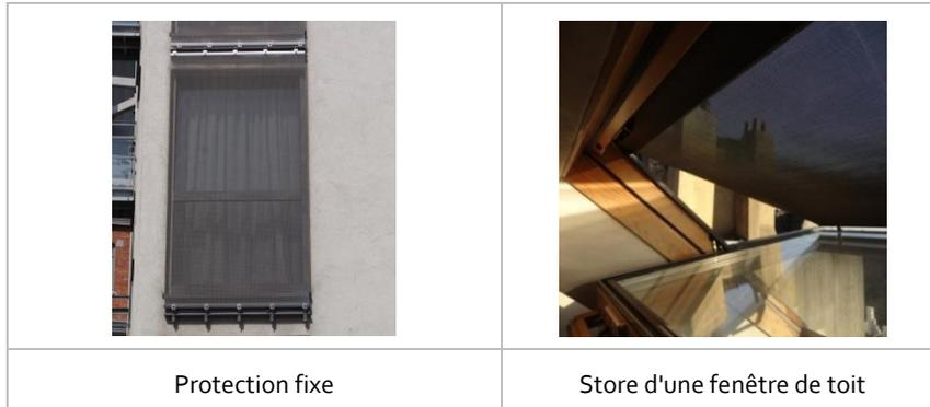
*Figure 35 – Protection solaire extérieure fixe*
