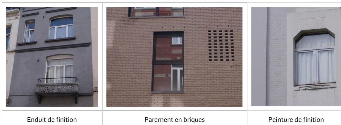
Figure 4 – Mur protégé des intempéries (Type n°2)
