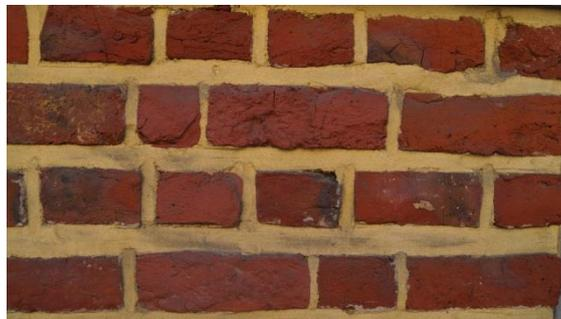
Figure 14 – Appareillage des briques: panneresse et boutisse
