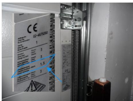
Figure 27 – Plaque signalétique d'une porte sectionnelle
