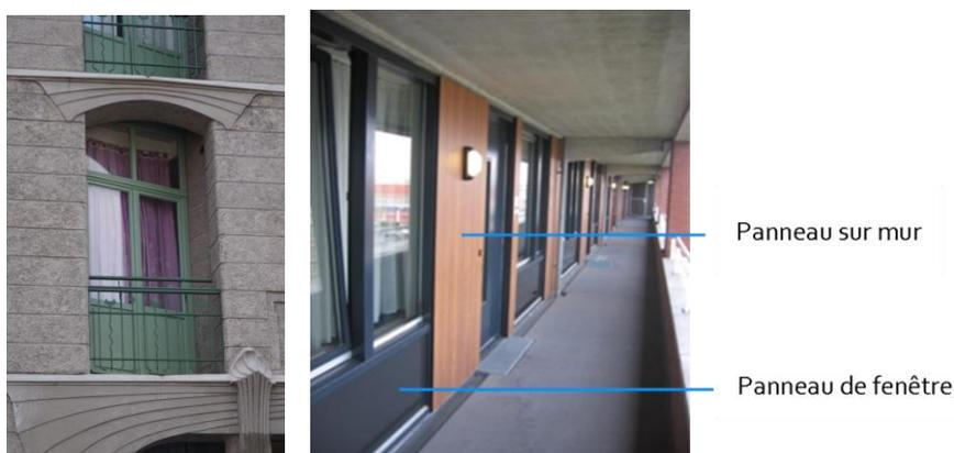
Figure 29 – Exemples de panneau de remplissage
