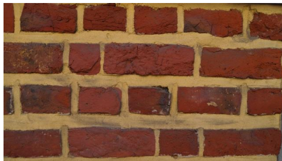
Afbeelding 14 – Legverband van de bakstenen: strek en kop
