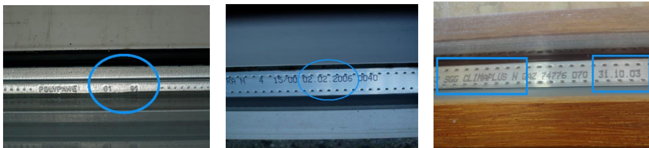
Afbeelding 21 – Metalen afstandhouders: productiedatum (merk en model)
