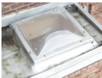
Afbeelding 25 – Enkelwandige koepel: beglazing van type 1
