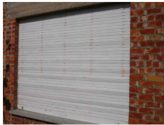
Afbeelding 36 – Van binnenuit bediend luik
