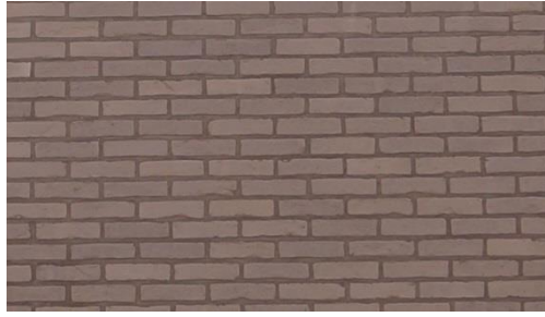
Afbeelding 13 – Legverband van de bakstenen: allemaal strekken
