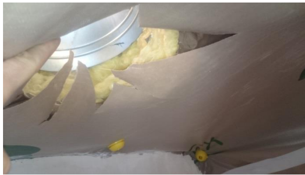
Vaststelling ter hoogte van een doorvoer
