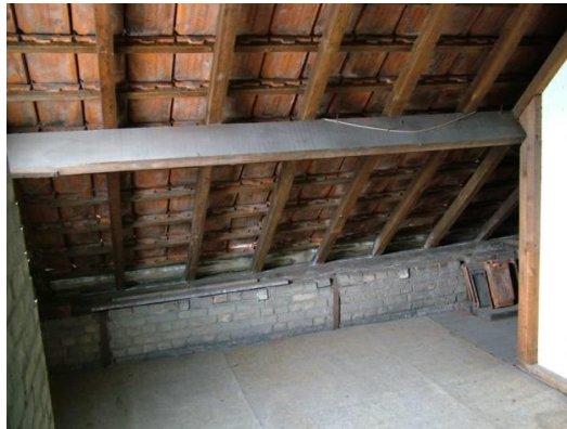
Afbeelding 17 – Muur onder de dakbalken
