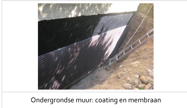
Afbeelding 5 – Bescherming tegen bodemvocht (muur van type 2)
