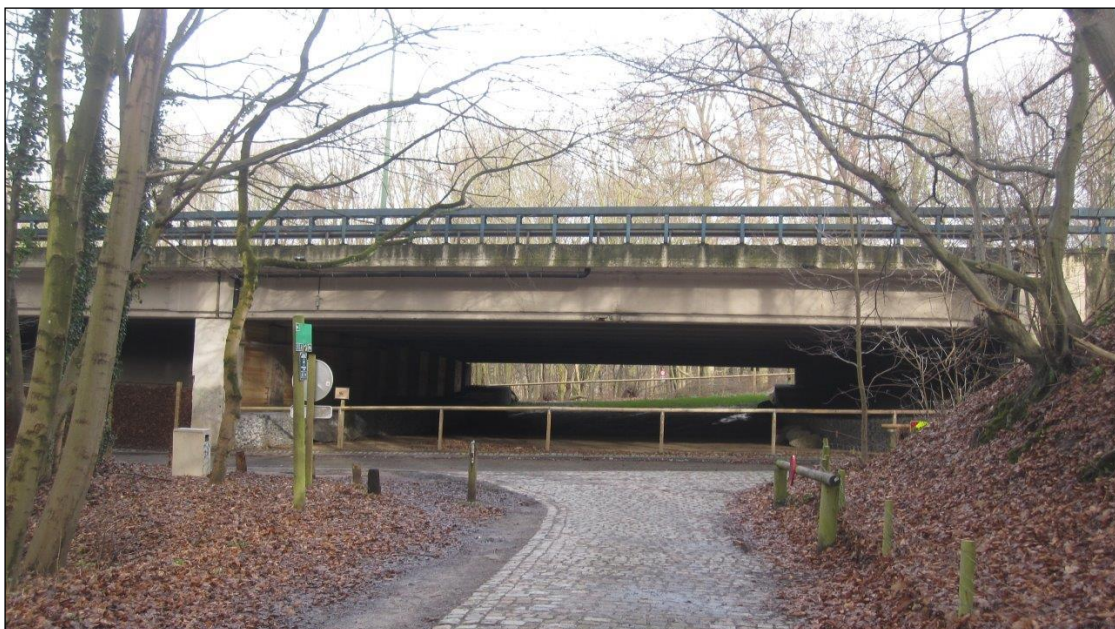
Foto 8.3 – Aanleg van een faunatunnel onder het viaduct Drie Fonteinen (2015)
