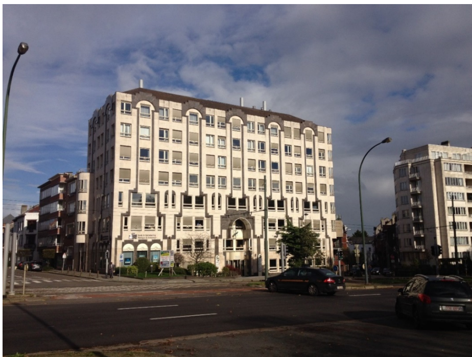
Figure 4 : Chien Vert – le bâtiment existant – source : MDW Architecture
