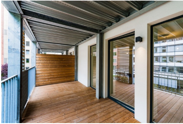
Figure 7 : Trèves – une structure de balcons indépendante a été installée à l’arrière du bâtiment – source : Archi 2000
