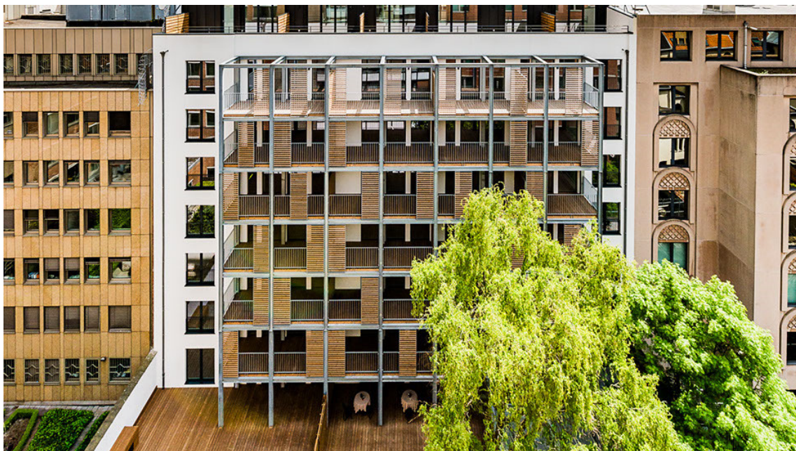
Figure 6 : Trèves – une structure de balcons indépendante a été installée à l'arrière du bâtiment – source : Archi 2000
