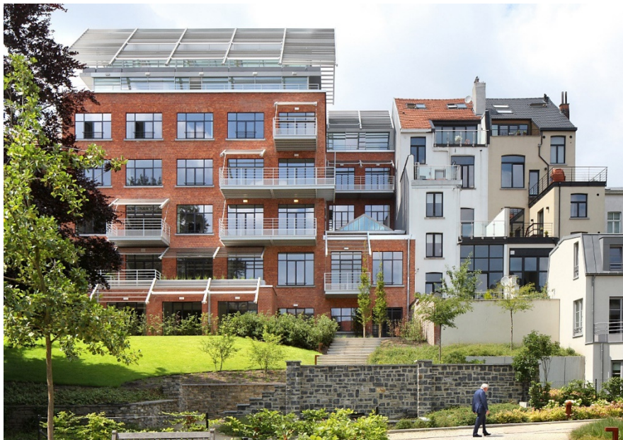
Figure 8 : Cross House – la façade arrière de l'immeuble après conversion – source : Ateliers Jean Nouvel-MDW Architecture – © F. Dujardin
