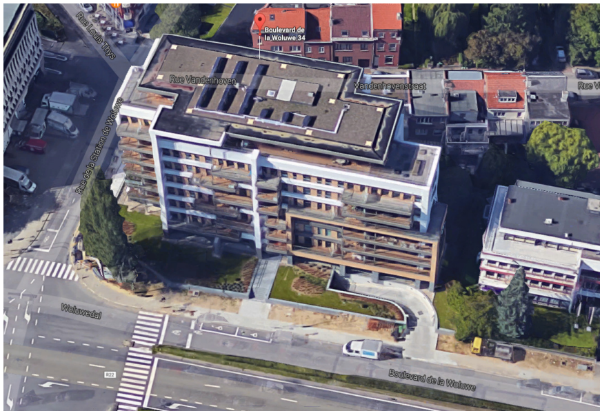
Figure 1 : L'immeuble situé au 34 boulevard de la Woluwe a été transformé en logements, l'entrée carrossable se fait à présent du côté du boulevard et le bâtiment a été articulé en trois volumes distincts – source : Google Maps
