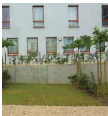
Désormais, les bâtiments éco-construits font partie du paysage bruxellois.
