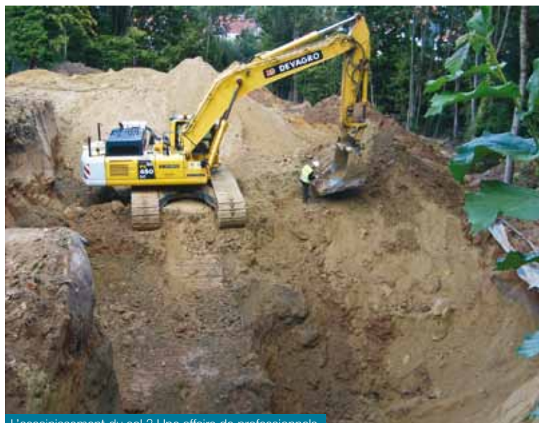
L'assainissement du sol ? Une affaire de professionnels.
