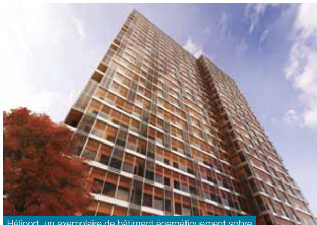
Héliport, un exemplaire de bâtiment énergétiquement sobre
