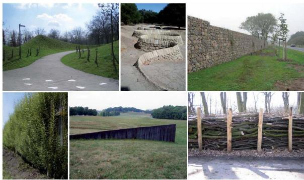
La performance acoustique d'un **mur anti-bruit** (en matériaux naturels ou artificiels) est déterminée par son emplacement, sa longueur et sa hauteur ainsi que par ses caractéristiques de transmission et de réflexion/absorption. Cacher la source a un effet psychologique sur la perception du bruit mais il faut néanmoins être attentif à ne pas obstruer les vues intéressantes depuis ou vers l'espace vert. Un choix judicieux de matériaux évitera également les réflexions vers les zones en vis-à-vis.
