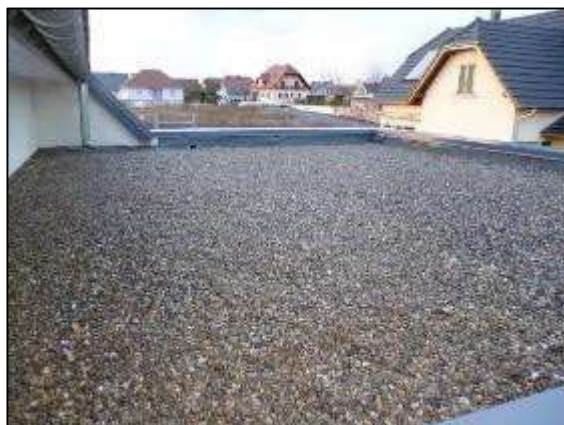
Afbeelding 44: Grinddak (Soprema)
