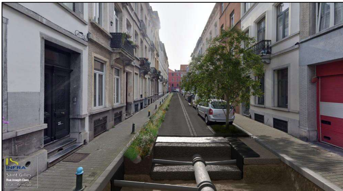
Afbeelding 16: Voorbeeld van de afgekoppelde Joseph Claesstraat (IS)
