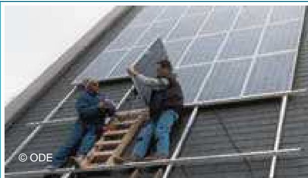
foto 4 : installatie van de modules
