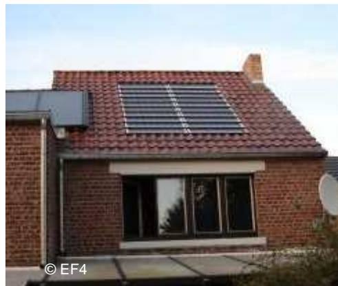
foto 2 : in het dak geïntegreerde panelen
