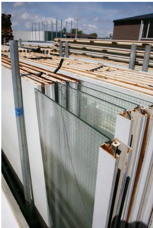
Parois amovibles démontées
