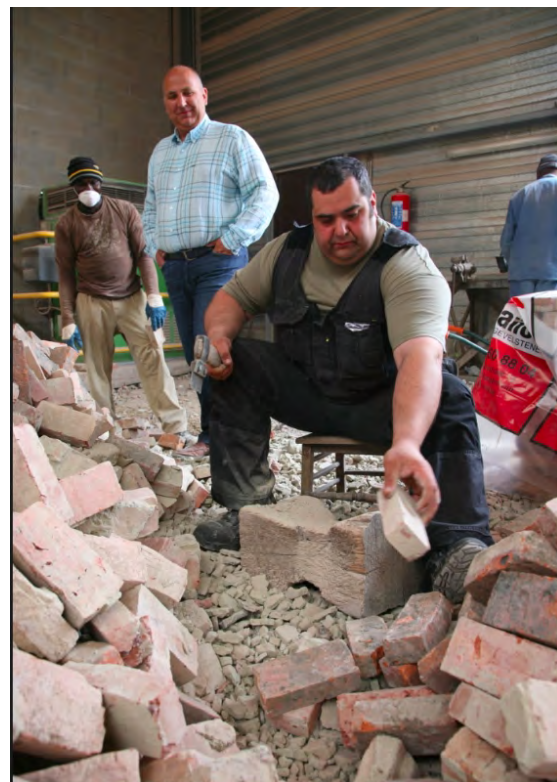
Test de faisabilité du nettoyage de brique par un moniteur de l'ETA APAM
