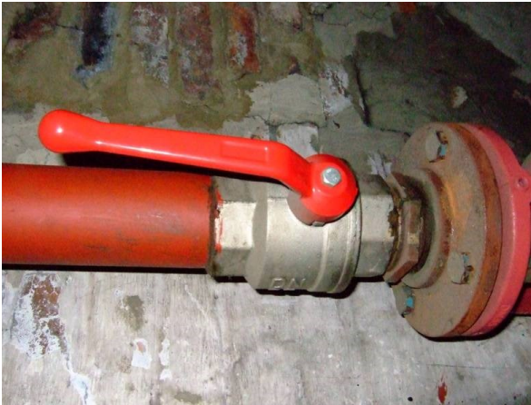
Figure 3.7: Vanne à boule et paire de brides
