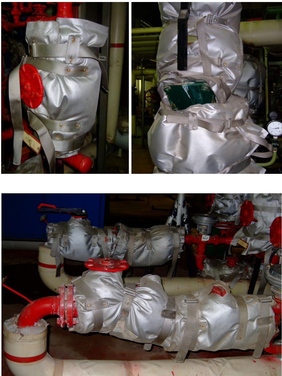
Figures 3.17: Calorifugeage d'accessoires avec matelas
