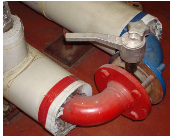
Figure 3.10: Vanne de réglage à papillon
