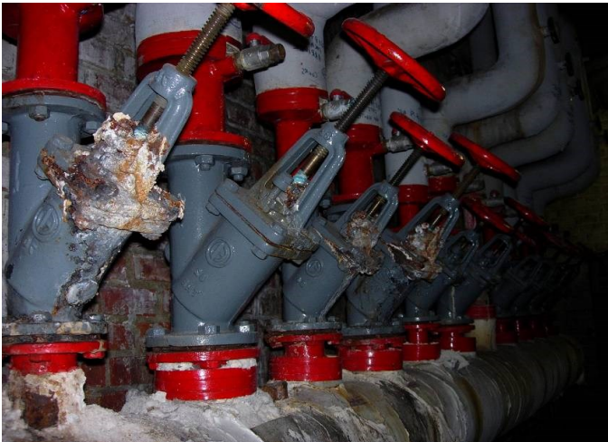
Figure 3.9: Vannes d'isolement à soupape à siège incliné (à calorifuger et à réparer)
