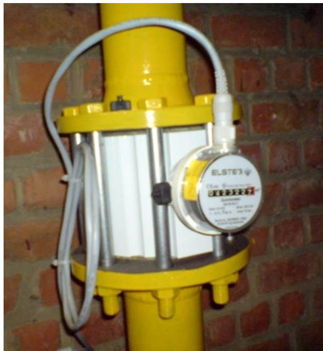
Figure 7.1: Compteur volumétrique de gaz
