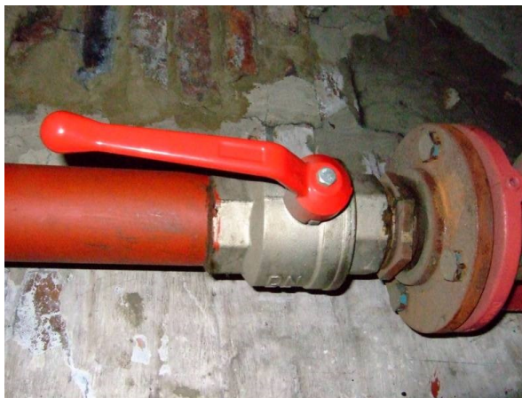
Figure 3.7: Vanne à boule et paire de brides
