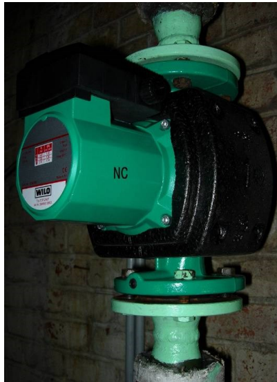
Figure 3.20: Coquille isolante moulée pour le corps de circulateur
