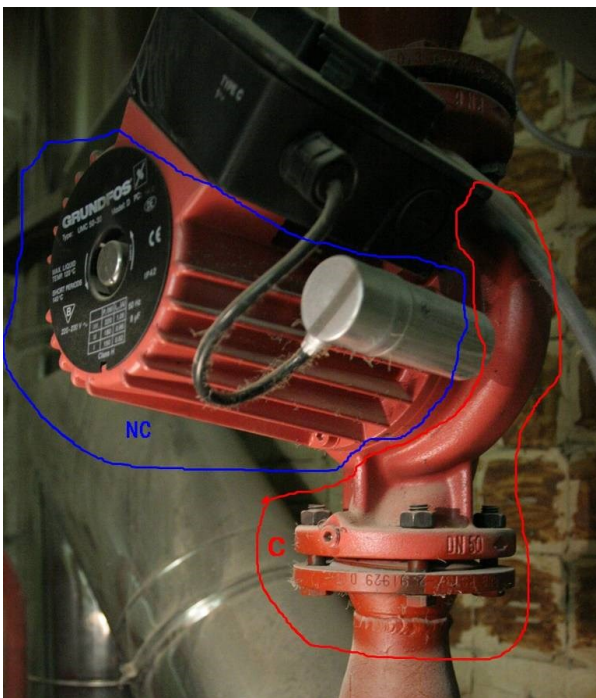
Figures 3.21: Parties d'un circulateur et d'une pompe à calorifuger ou non.
