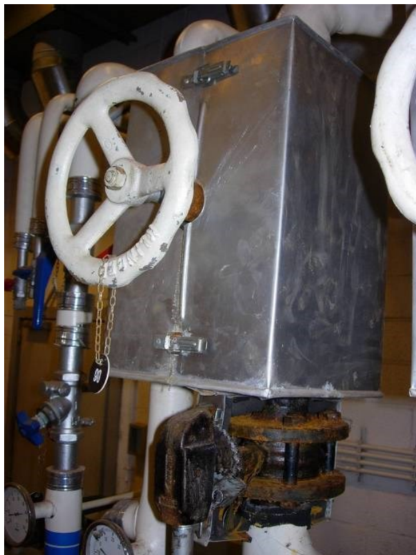
Figure 3.18: Capot monté sur une vanne
