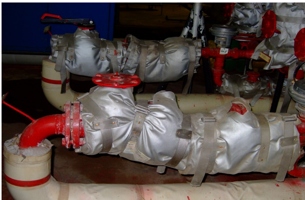
Figures 3.17: Calorifugeage d'accessoires avec matelas
