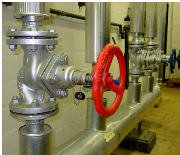
Figure 3.8: Vannes d'isolement à soupape à siège droit
