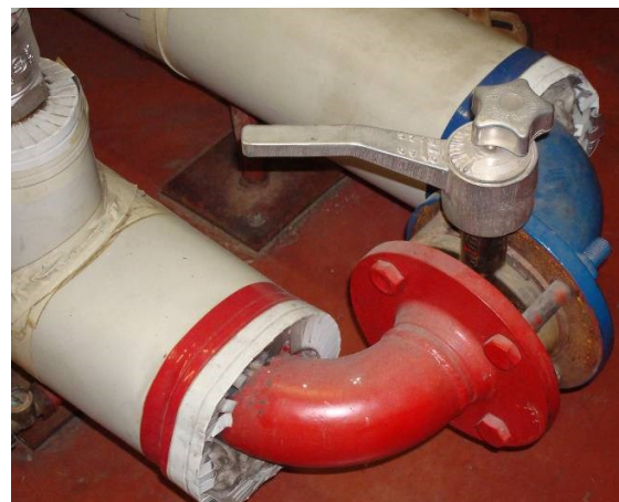
Figure 3.10: Vanne de réglage à papillon
