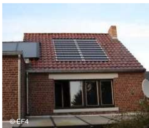
photo 2 : intégration des panneaux dans le toit
