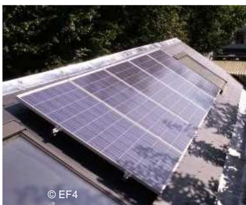
photo 1 : système de superstructure
