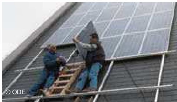
photo 4 : installation en cours des modules
