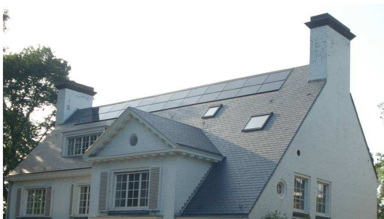
Figure 7 : Exemple de modules PV intégrés dans une toiture en ardoise (Hespul - APERe)
