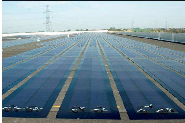
Figure 5: Système constitué de modules au silicium amorphe collés sur la membrane d'étanchéité de la toiture. Projet Colruyt, Halle. [Hespul - Photo Colruyt].
