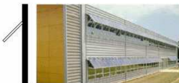
Figure 10 : Exemple de brise soleil (Hespul)
