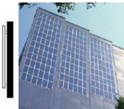
Figure 8 : Exemple de pose verticale de modules (Hespul)
