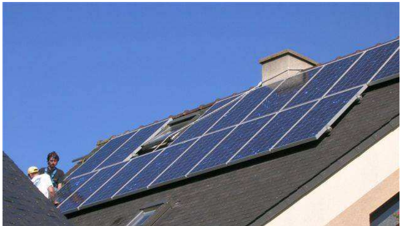
Figure 6 : Exemple de modules PV en surimposition de toiture en ardoise (Hespul - 3E)
