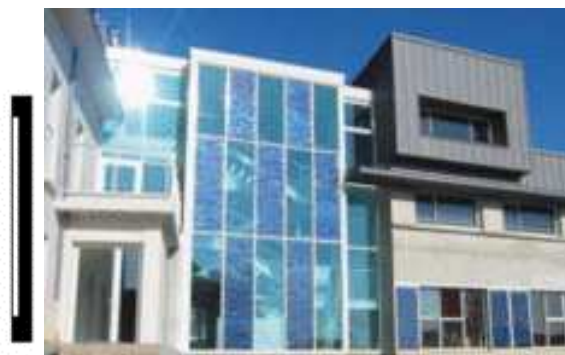
Figure 9 : Exemple d'intégration en façade (Hespul)
