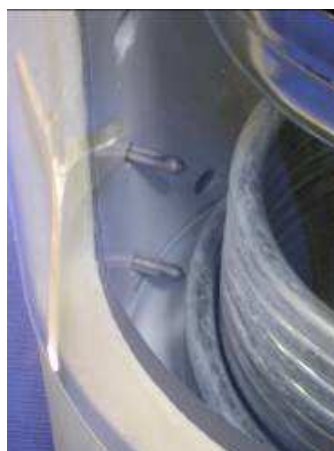
Photos 21 et 22 : Sonde en applique (gauche) ou en « doigt de gant » (droite), ici dans un ballon de stockage.
