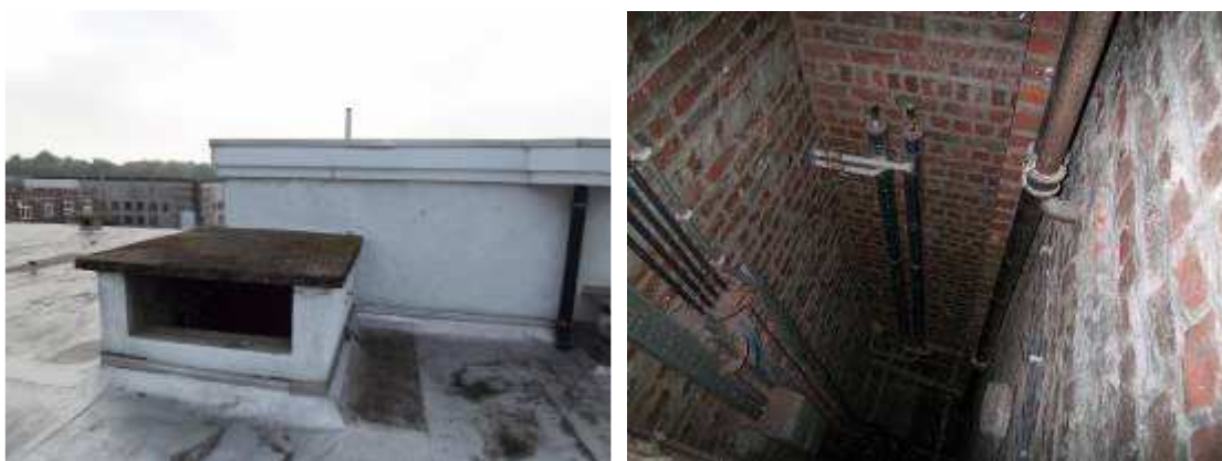
Photos 1 et 2 : Gaine technique reliant la toiture au sous-sol
