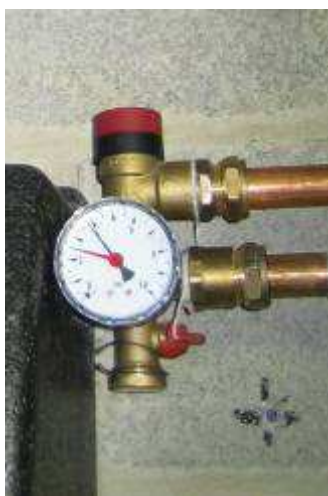
Photo 3 : Manomètre indiquant la pression du circuit primaire. (Soupape de sécurité = capuchon rouge)
