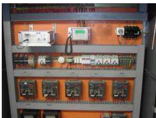
Photos 11 et 12 : Tableau de contrôle et tableau électrique
