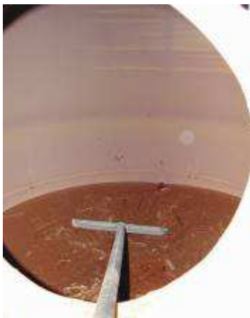
Photos 14 et 15 : Nettoyage de la boue dans le bas d'un réservoir et vue externe.
