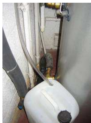
Photos 8 et 9 : Soupape de sécurité et bac récolteur du fluide caloporteur antigel
