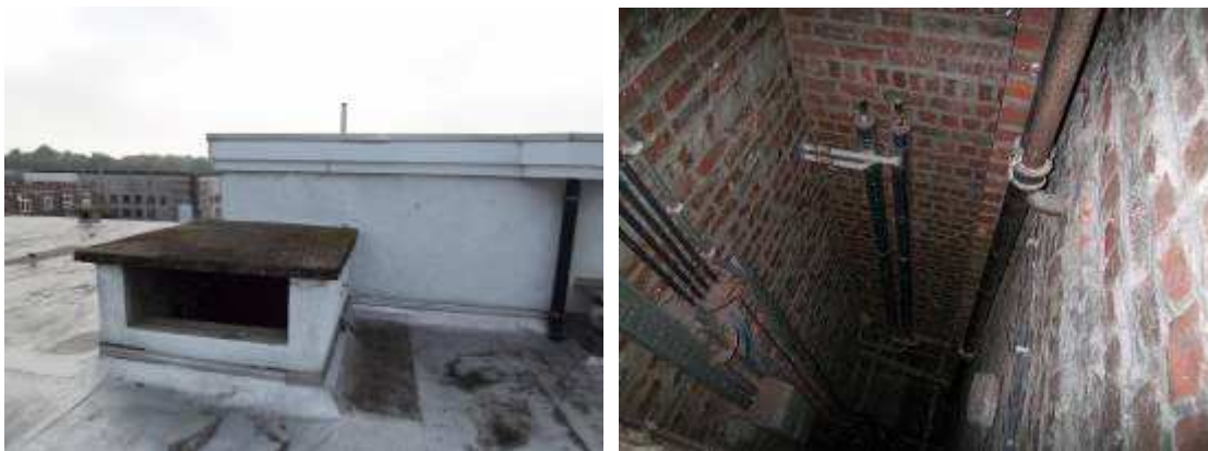
Foto's 1 en 2 : Een technische schacht verbindt het dak met de kelder
