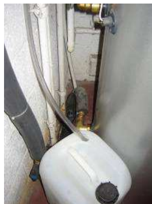
Foto's 8 en 9 : Veiligheidsklep en terugloopvat voor de warmtegeleidende vloeistof met antivries
