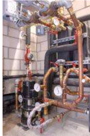
Foto's 5 en 6 : Debietmeting en een circulatiepomp in het primaire circuit
