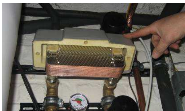
Foto's 18 en 19 : Platenwarmtewisselaars
