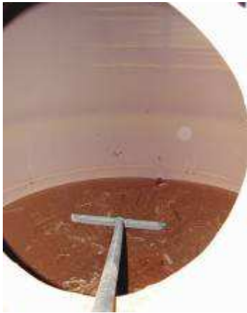
Foto's 14 en 15 : Tijdens een reinigingsbeurt wordt het slib verwijderd van de bodem van een vat – foto rechts: het buitenaanzicht van een opslagvat.
