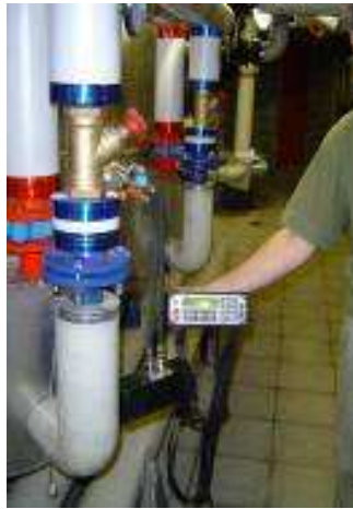
Foto's 5 en 6 : Debietmeting en een circulatiepomp in het primaire circuit
