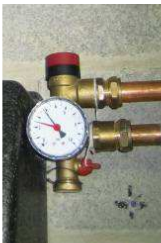
Foto 3 : De manometer geeft de druk in het primaire circuit weer. (Veiligheidsklep = rode dop)
