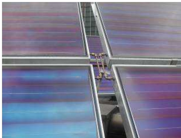
Foto 7 : Vlakkeplaatcollector onder glas
