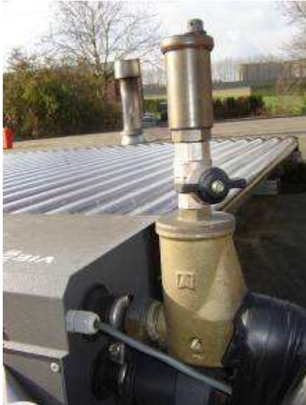
Foto 10 : Manuele ontluuchtingskraan op een hoog punt van het primaire circuit
