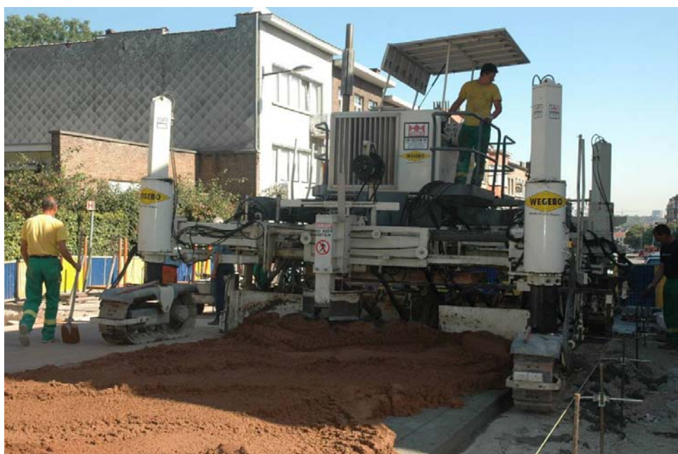
Ganshoren : mechanisch aanbrengen van een gekleurd stortbeton
