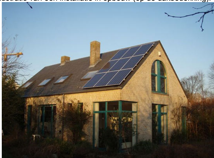
Figuur 6 : Installatie van 2 kWp - Brussel, België (foto Issol)
