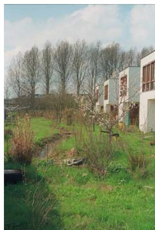
Gauche: surface imperméabilisée décorée de rigoles à ciel ouvert. Droite: L'eau est collectée dans des fossés à ciel ouvert (photos: VIBE)
