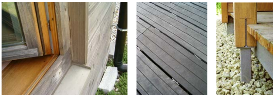
links: houten buitenschrijnwerk kan u om technische redenen best schilderen of beitsen; hout met een duurzaamheidsklasse I, II of III kan u onbehandeld gebruiken; midden: door gebruik te maken van een kliksysteem kan het hout aan alle zijden gemakkelijk uitdrogen; rechts: rechtstreeks grondcontact van houten speeltoestellen of terrassen wordt best vermeden.
