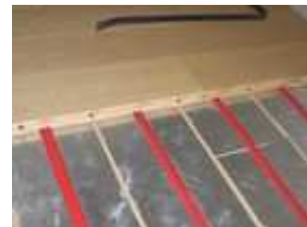
Vloerverwarming met lage inertie (Bron: http://www.opal-systems.be . Ter illustratie)
