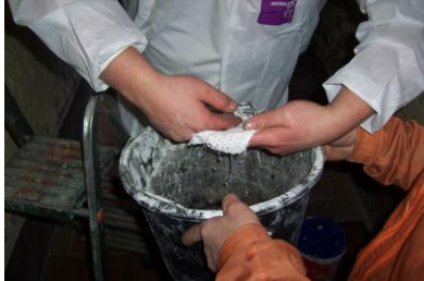
1. Voorbereiding van de pleisterstroken
