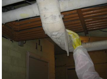
2. De pleisterstroken aanbrengen op de isolatie van de buizen
