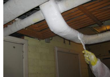
3. Een speciale verf aanbrengen op de stroken
