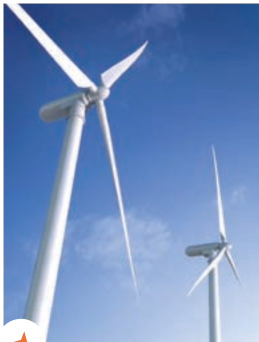
Des éoliennes pour une énergie plus verte.
