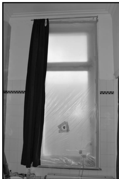
Luchtdichte film geplaatst op binnenkader
