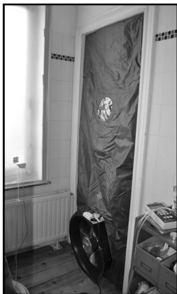
Ventilator creëert onderdruk in het lokaal (in dit geval)
