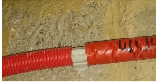
Afbeelding 41 – Gedeeltelijke isolatie (stuk aan rechterzijde) van een meerlaagse buis
