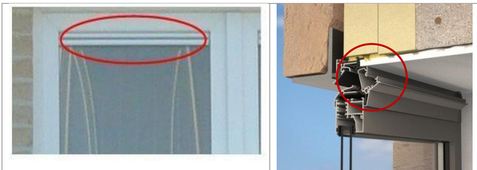
Afbeelding 66 – Toevoeropening geïntegreerd in het profiel van een venster
