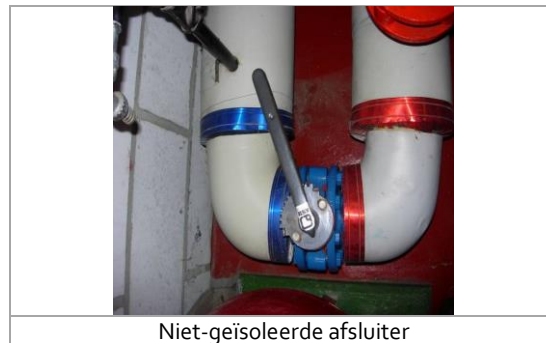
Afbeelding 43 – Gedeeltelijke isolatie van verwarmingsleiding
