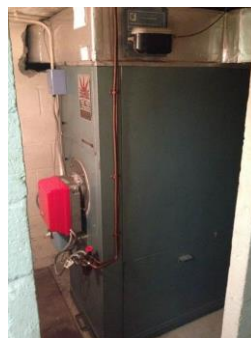
Afbeelding 16 – Warmeluchtgenerator
