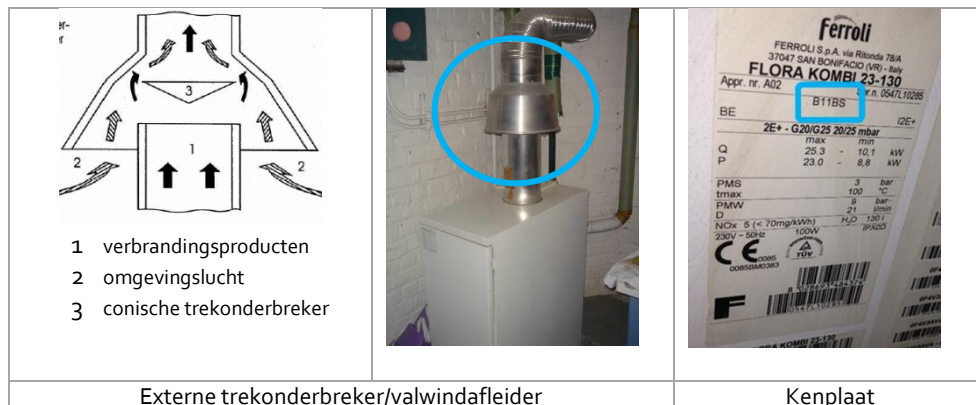
Afbeelding 15 – Externe trekonderbreker/valwindafleider
