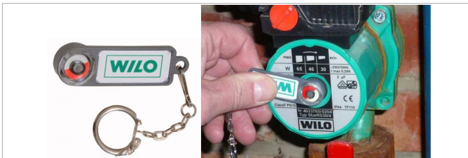
Afbeelding 46 – Magneet om de werking van de circulatiepomp te controleren
