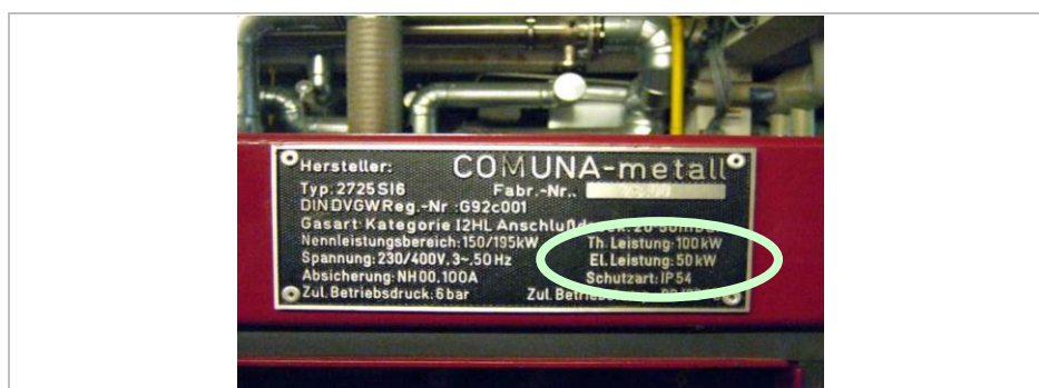
Illustration 32 – Plaque signalétique d'une cogénération et puissance électrique
