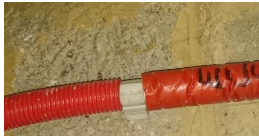
Illustration 41 – Isolation partielle (tronçon à droite) d'un tuyau multicouches
