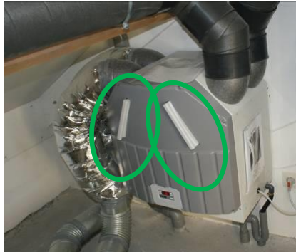
Illustration 69 – Exemple d'un récupérateur de chaleur
