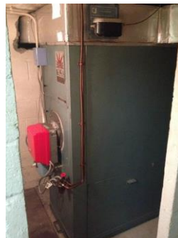
Illustration 16 – Générateur à air chaud
