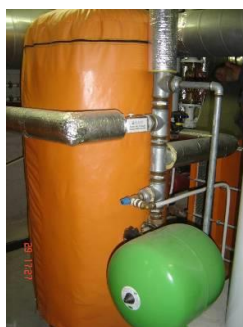
Illustration 62 – Réservoir isolé
