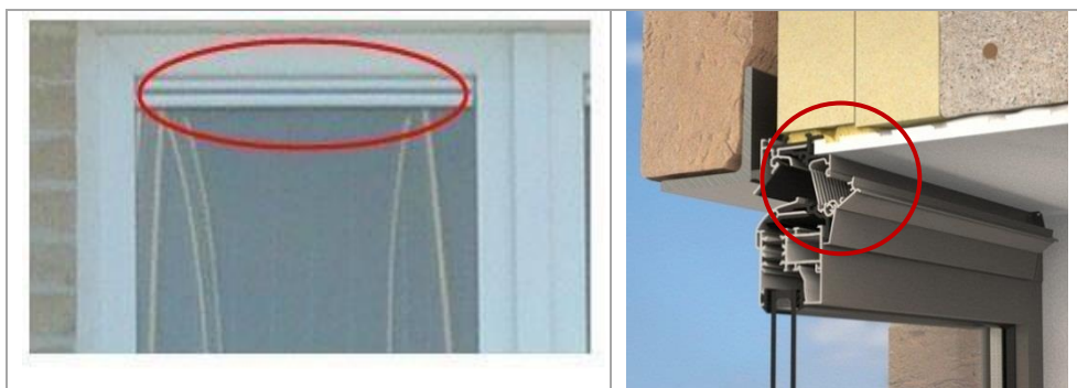
Illustration 66 – Ouverture d'alimentation intégrée au châssis de fenêtre
