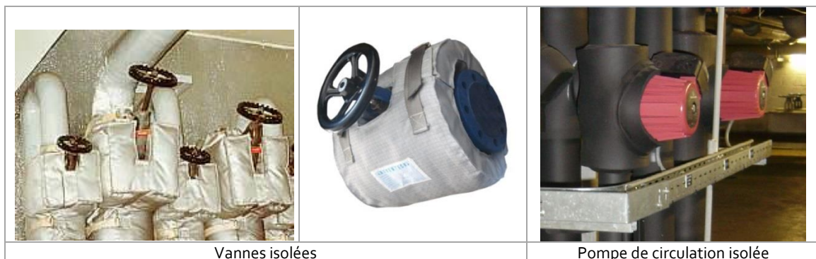
Illustration 42 – Isolation complète de vannes et de pompes
