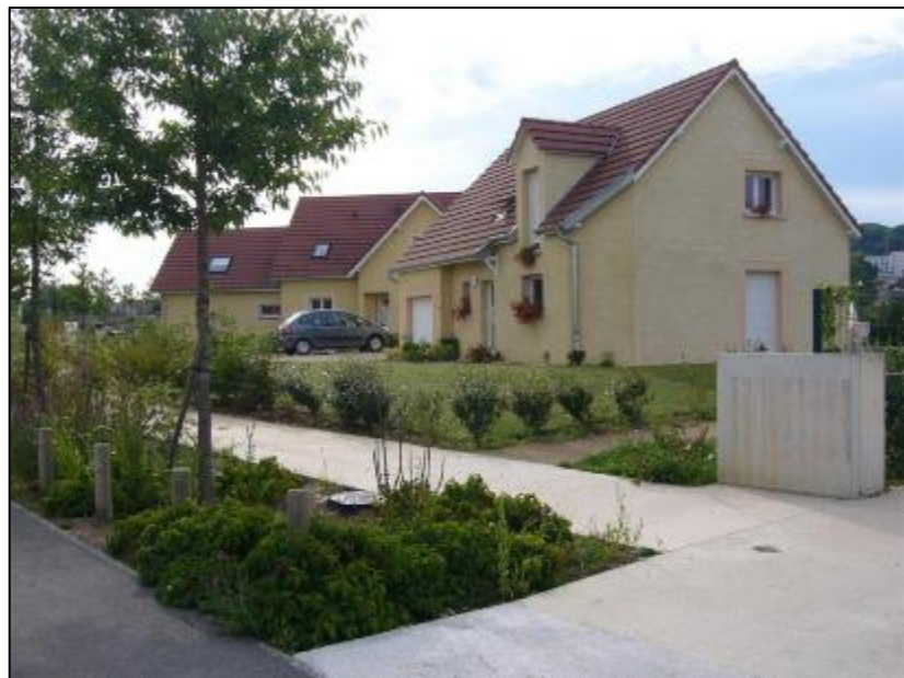
Figure 37 : Photo d'une noue plantée avec piétonnier (IS)
