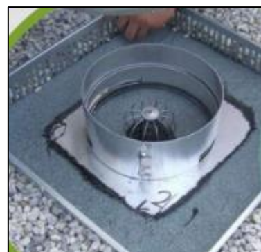
Figure 48 : Limiteur de débit en toiture (Débit-co)
