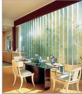
Afbeelding 23 – Muur in profielglas
