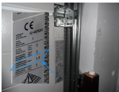
Afbeelding 27 – Kenplaatje van een sectionaalpoort
