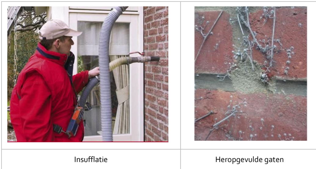
Afbeelding 18 – Vaststelling ter plaatse van een na-isolatie
