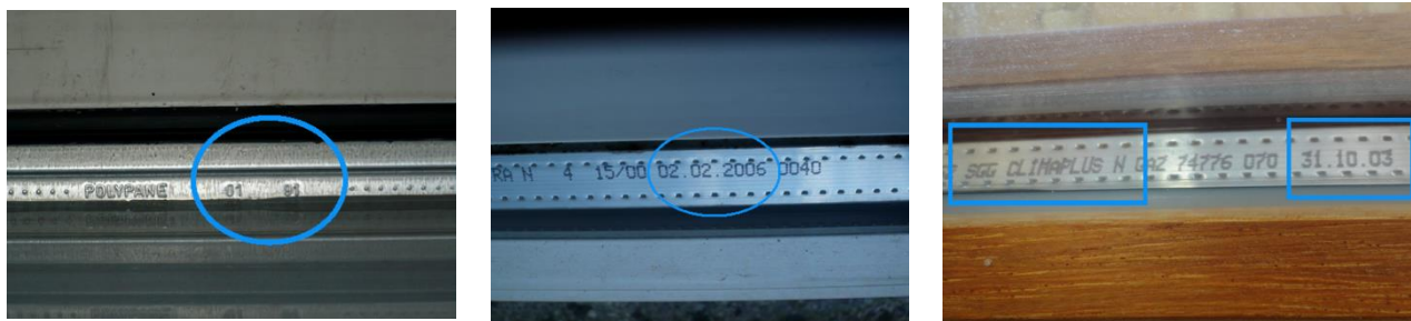
Afbeelding 21 – Metalen afstandhouders: productiedatum (merk en model)
