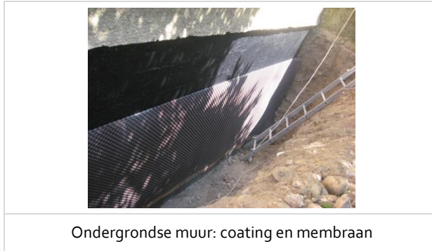
Afbeelding 5 – Bescherming tegen bodemvocht (muur van type 2)
