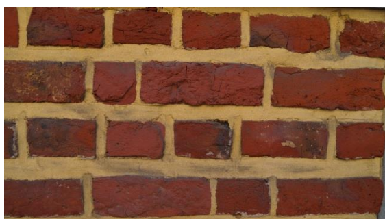
Afbeelding 14 – Legverband van de bakstenen: strek en kop
