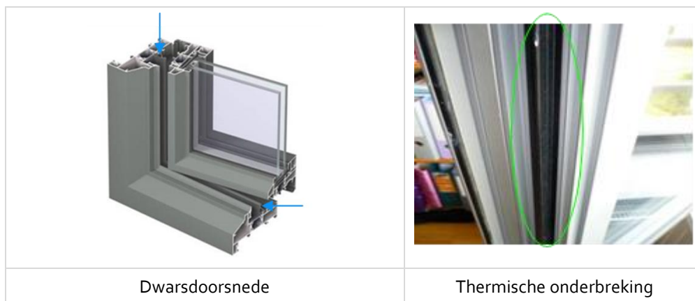
Afbeelding 31 – Metalen kozijn met thermische onderbreking
