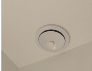
Afbeelding 69 – Toevoering, wijzend op mechanische luchttoevoer
