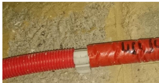
Afbeelding 42 – Gedeeltelijke isolatie (stuk aan rechterzijde) van een meerlaagse buis
