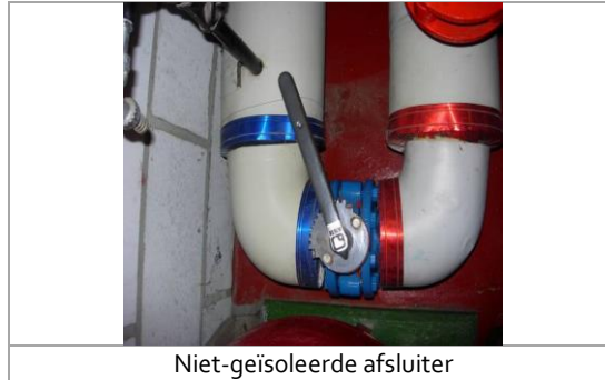
Afbeelding 44 – Gedeeltelijke isolatie van verwarmingsleiding
