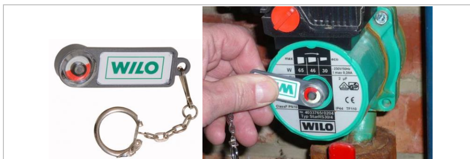
Afbeelding 47 – Magneet om de werking van de circulatiepomp te controleren
