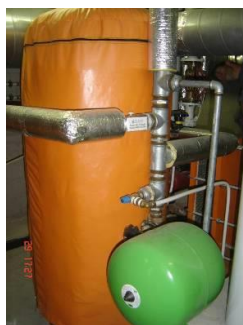
Afbeelding 64 – Geïsoleerd voorraadvat
