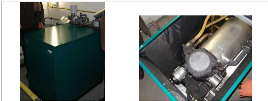
Afbeelding 23 – Warmtekrachtkoppeling met bekleding (links) en zonder bekleding (rechts)
