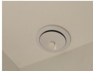
Afbeelding 69 – Toevoering, wijzend op mechanische luchttoevoer
