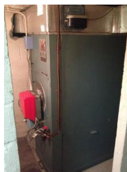
Afbeelding 16 – Warmeluchtgenerator
