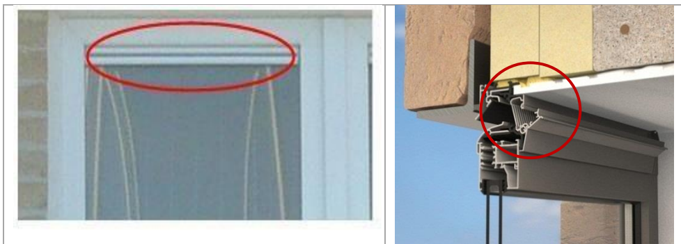
Afbeelding 68 – Toevoeropening geïntegreerd in het profiel van een venster
