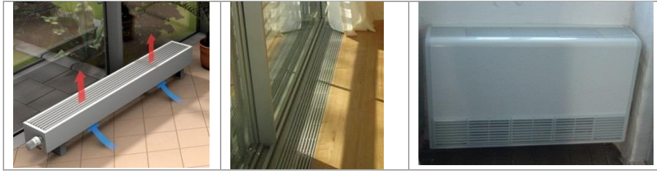
Afbeelding 49 – Illustratie van de aanwezigheid van een convector
