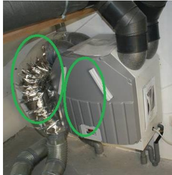
Afbeelding 71 – Voorbeeld van een warmteterugwineenheid
