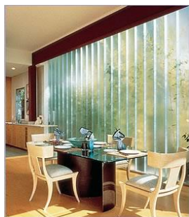
Afbeelding 23 – Muur in profielglas
