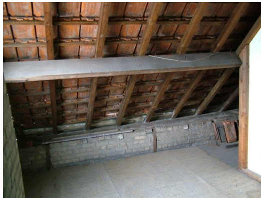
Afbeelding 17 – Muur onder de dakbalken
