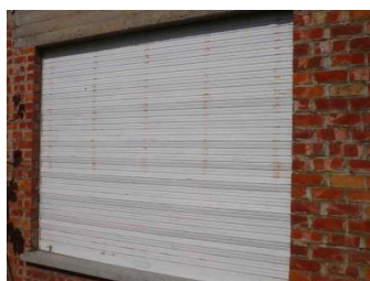
Afbeelding 36 – Van binnenuit bediend luik
