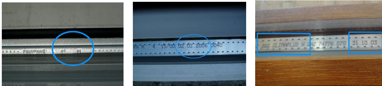
Afbeelding 21 – Metalen afstandhouders: productiedatum (merk en model)
