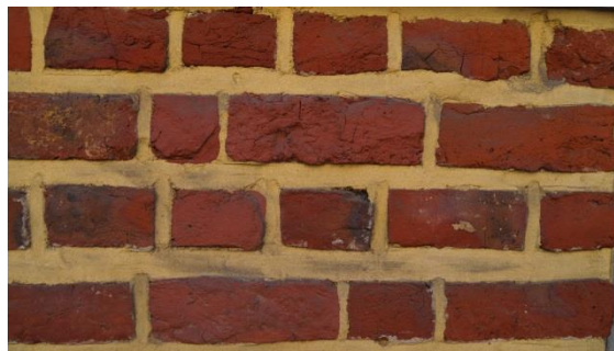
Afbeelding 14 – Legverband van de bakstenen: strek en kop
