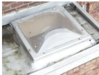
Afbeelding 25 – Enkelwandige koepel: beglazing van type 1
