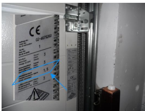
Afbeelding 27 – Kenplaatje van een sectionaalpoort
