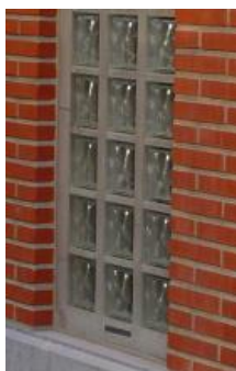
Afbeelding 24 – Afdichting van een muuropening met glasbouwstenen
