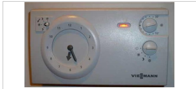
Illustration 38 – Thermostat d'ambiance (exemple à horloge)
