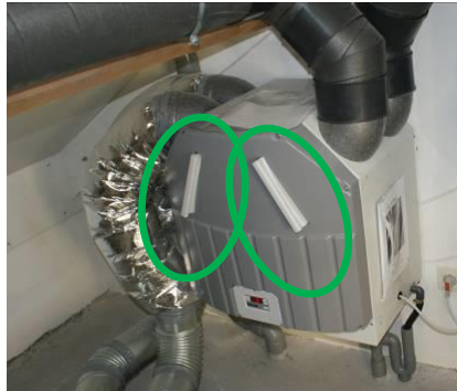
Illustration 71 – Exemple d'un récupérateur de chaleur
