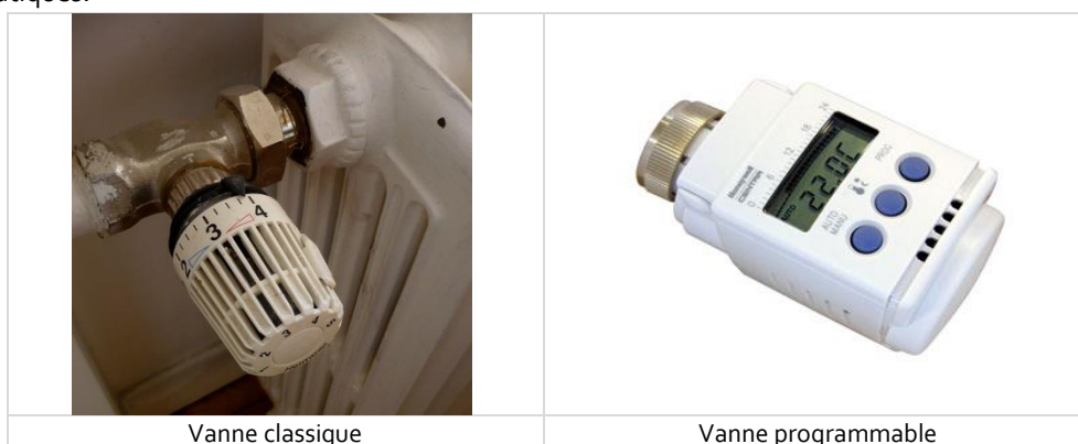
Illustration 51 – Vannes thermostatiques
