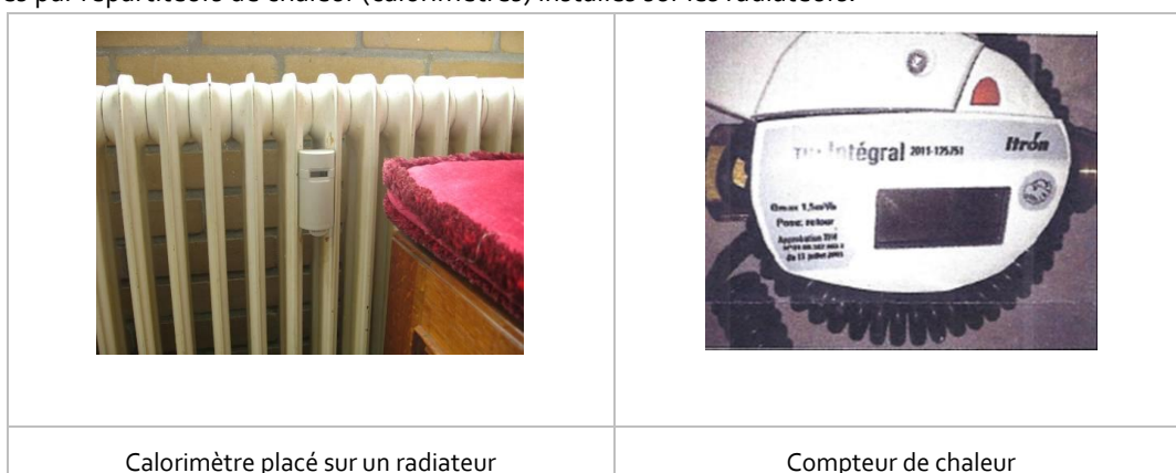
Illustration 53 – Comptage individuel des frais de chauffage
