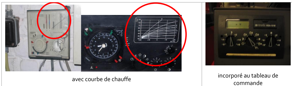
Illustration 40 – Régulateurs climatiques
