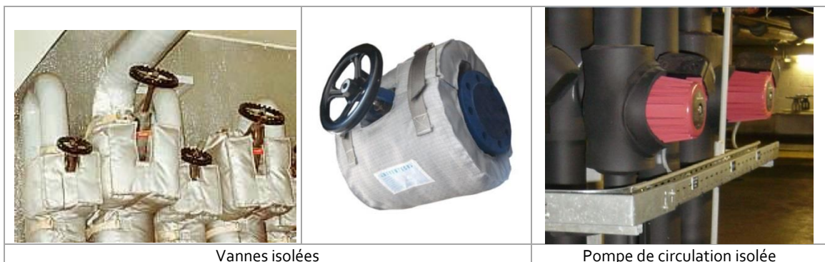
Illustration 43 – Isolation complète de vannes et de pompes
