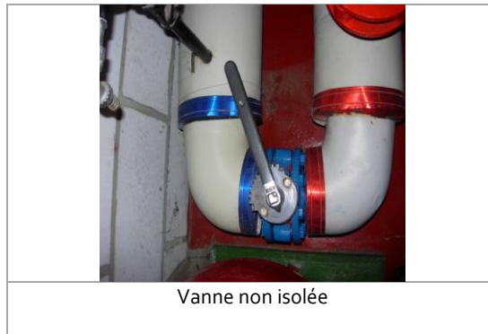
Illustration 44 – Isolation partielle de conduites de chauffage
