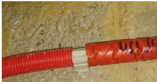
Illustration 42 – Isolation partielle (tronçon à droite) d'un tuyau multicouches
