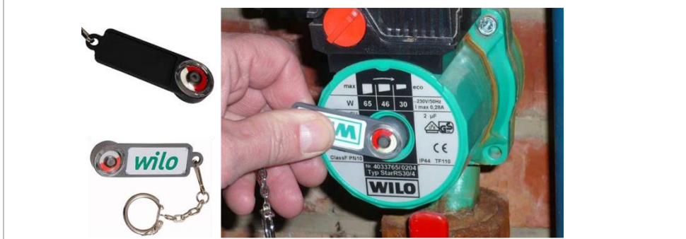
Illustration 47 – Aimant pour constater le fonctionnement d'un circulateur
