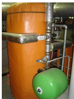
Illustration 64 – Réservoir isolé
