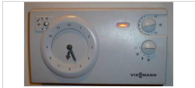
Illustration 38 – Thermostat d'ambiance (exemple à horloge)
