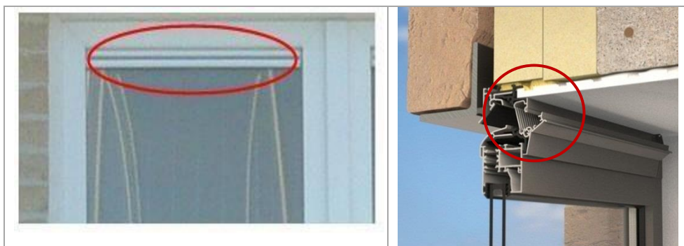
Illustration 68 – Ouverture d'alimentation intégrée au châssis de fenêtre
