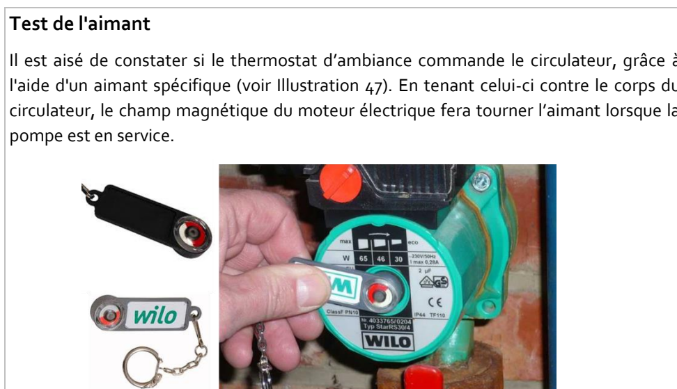
Illustration 47 – Aimant pour constater le fonctionnement d'un circulateur
