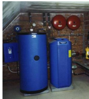
Illustration 61 – Installation collective avec des ballons de stockage
