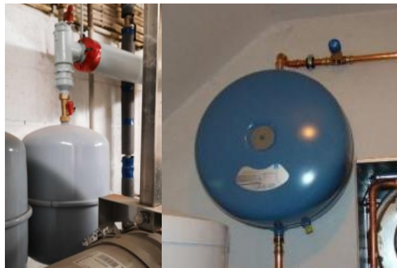
Illustration 63 – Vases d'expansion reliés au circuit d'ECS en un point (gauche) et en ligne (droite)
