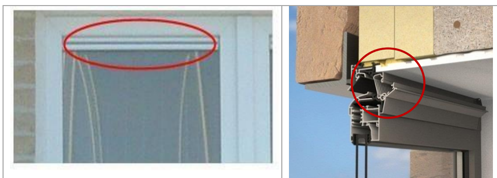
Illustration 68 – Ouverture d'alimentation intégrée au profilé de fenêtre
