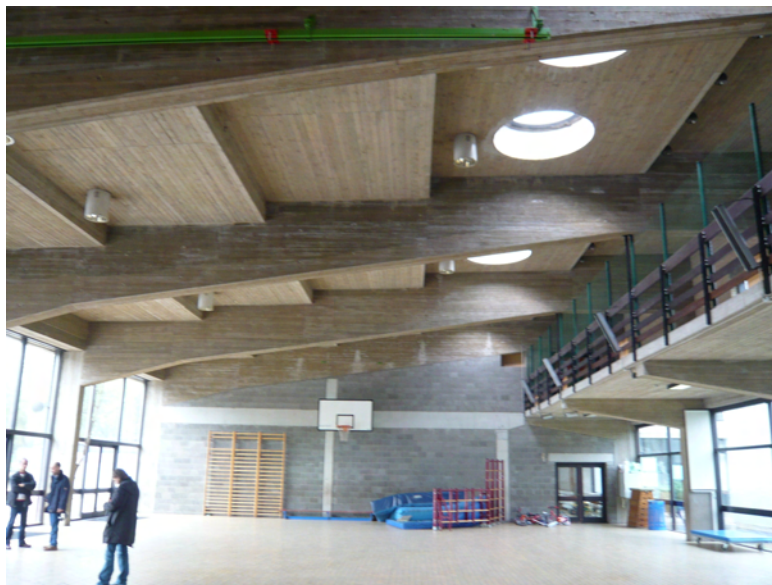
photo de la salle de gymnastique (source: CEDIA, 2009)
