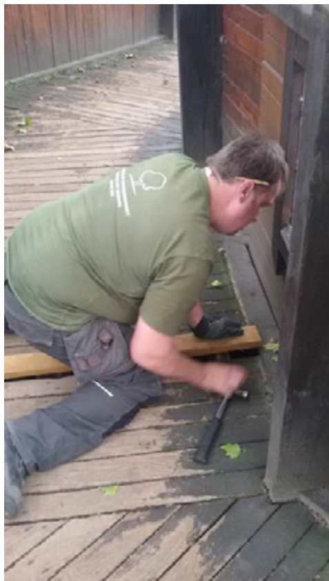
Onderhoud van het speelplein aan de Hallepoort.
