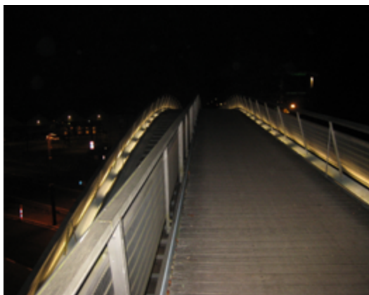
Loopbrug van de Groene wandeling over de spoorweg in Sint-Lambrechts-Woluwe.
