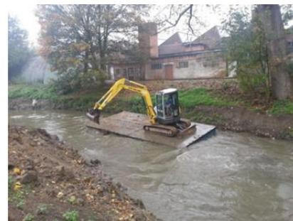
Figure 22 : Curage de la Senne et aménagement de ses abords (source : <http://www.bruplus.irisnet.be>)
