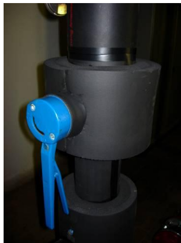
Figuur 8.4 – Thermische isolatie van accessoires
