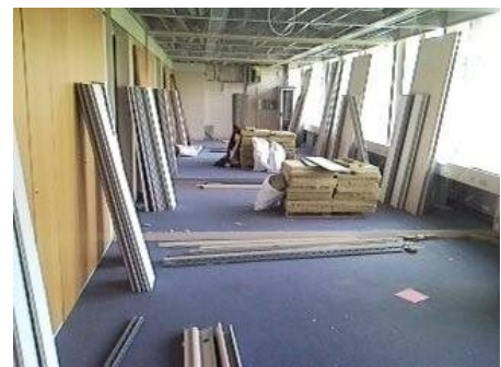
Remise à nu d'un plateau de bureaux (source: www.vdl-demontage.nl )
