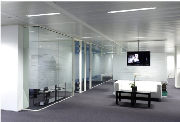
En matière de cloisons vitrées, la tendance actuelle est aux vitres bords à bords. (image: www.tecnibo.eu )
