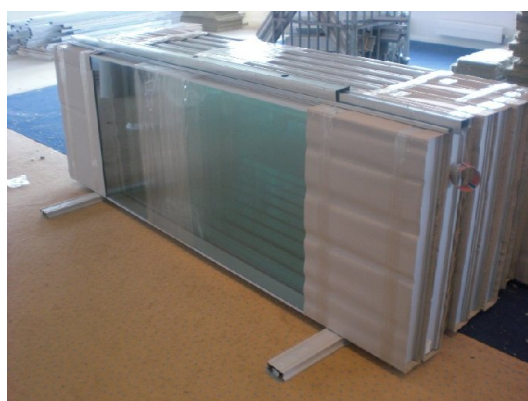
Cloison vitrée démontée et conditionnée pour le transport (source: www.vdl-demontage.nl )
