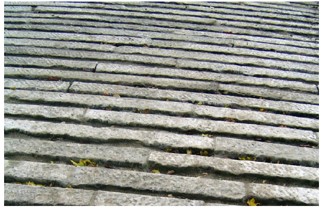
Mise en œuvre de bordures de réemploi en tant que pavage/casse-vitesse, parc Maria Hendrika à Ostende. Source : www.denisdujardin.be
