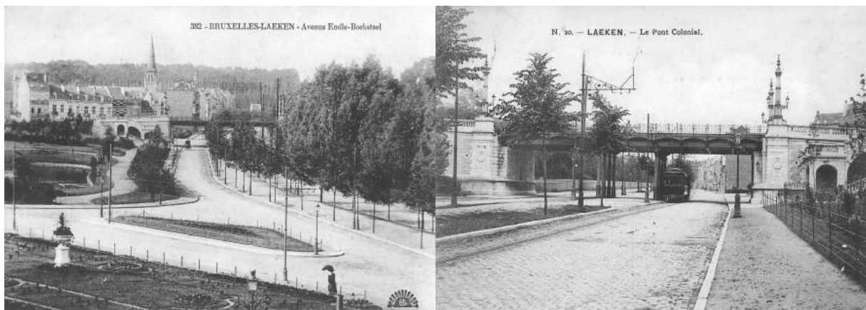
Figure 11: Cartes postales représentant le prolongement du boulevard Bockstaël et le pont colonial vers 1910 (le fruitier royal se trouve à droite sur la première photo, à gauche sur la seconde). Source : Geschied- en Heemkundig Kring LACA [en ligne, juillet 2019 : http://www.laken-ingezoomd.be/ ]
