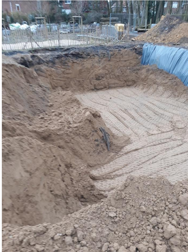
Photo 11 : Compactage du sable de remblai
