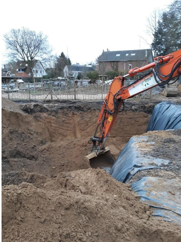
Photo 9 : Reprise complète de la paroi Ouest
