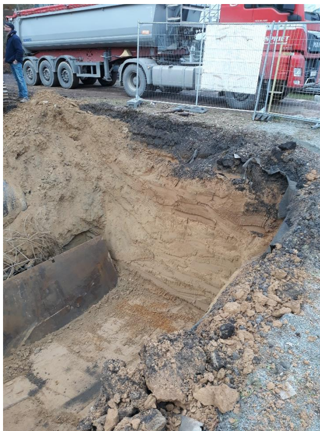
Photo 4 : paroi Nord et fond de fouille côté Est en fin d'excavation (4m-ns)
