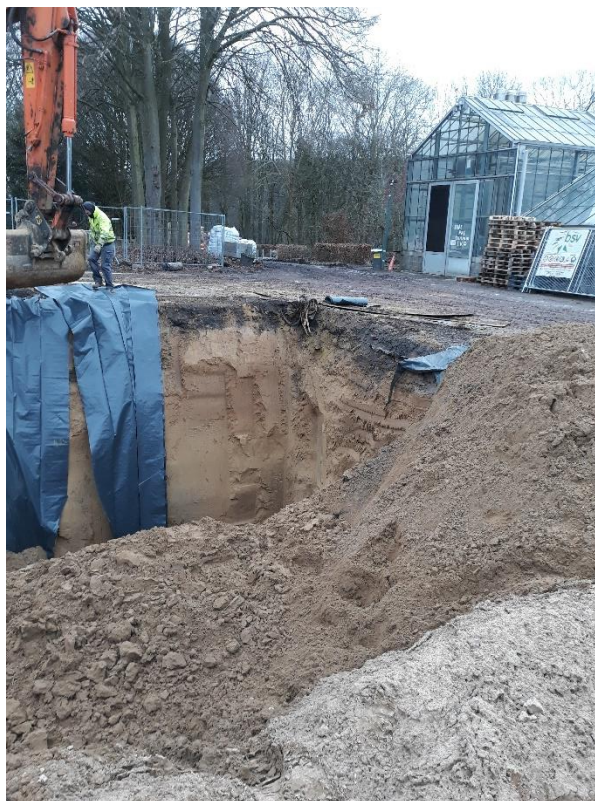
Photo 10 : Parois Nord et Ouest en fin d'excavation (5 m-ns)
