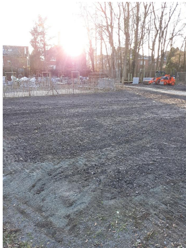
Photo 12 : Zone de chantier après remise en état
