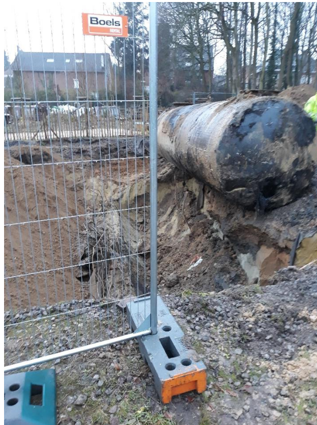
Photo 5 : Evacuation du réservoir R1
